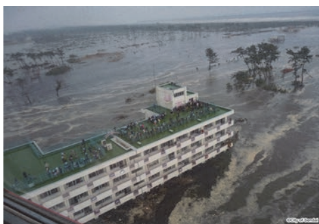
City of Sendai (2011)「津波で孤立する荒浜小学校」 Accessed 12 September 2024, https://www.city.sendai.jp/shiminkoho/shise/dai-shinsai/zenkoku/photoarchive/engan/009.html
